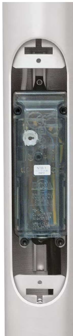
Stožárová svorkovnice pod dvířky hliníkového stožáru
