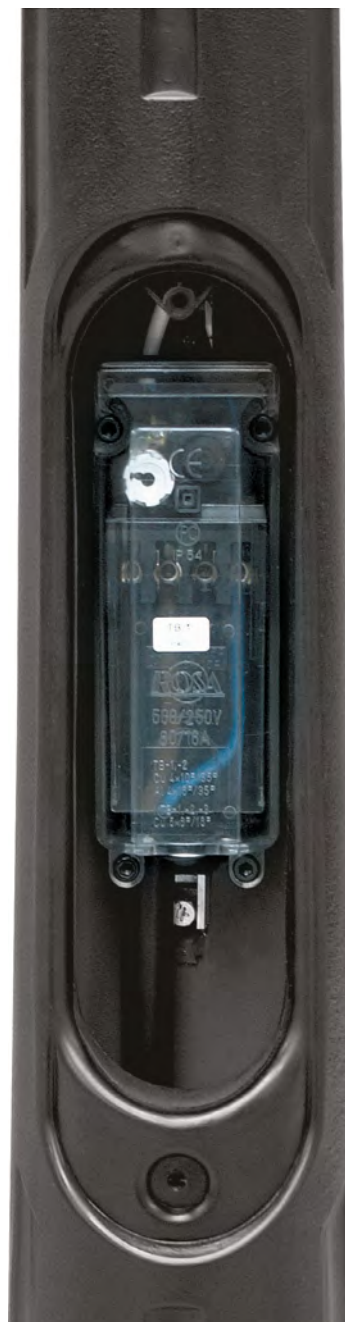
Stožárová svorkovnice pod dvířky historického stožáru
